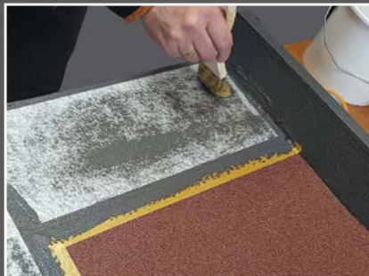
Zatopienie zbrojenia N-Tex
